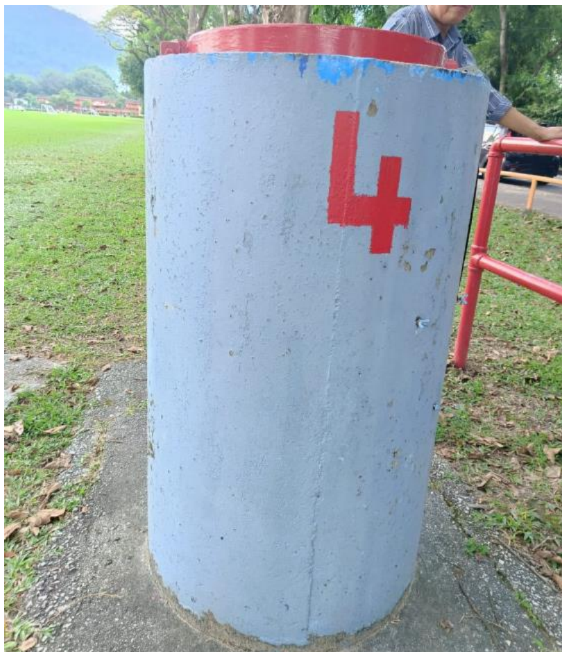
Gambar 3: Keadaan pillar di Tapak Ujian EDM Padang Polo, Jalan Sepoi Lines, Pulau Pinang
